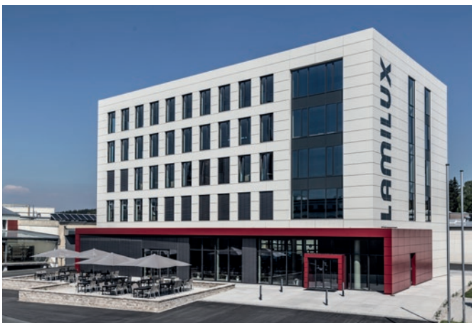
Bürogebäude am Hauptsitz des Unternehmens in Rehau
